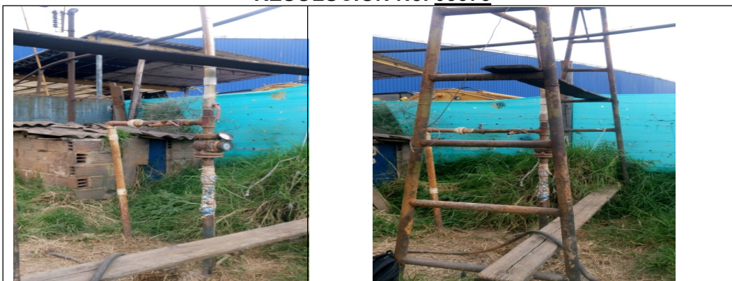
Fotos 3 y 4. Estructura del pozo pz-06-0003
