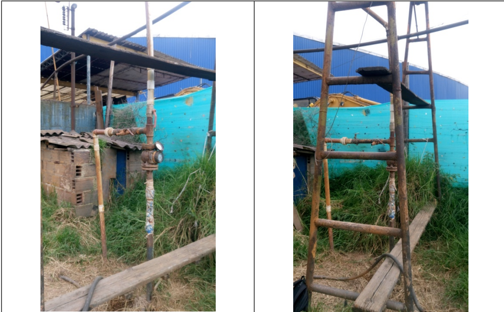
Fotos 3 y 4. Estructura del pozo pz-06-0003
